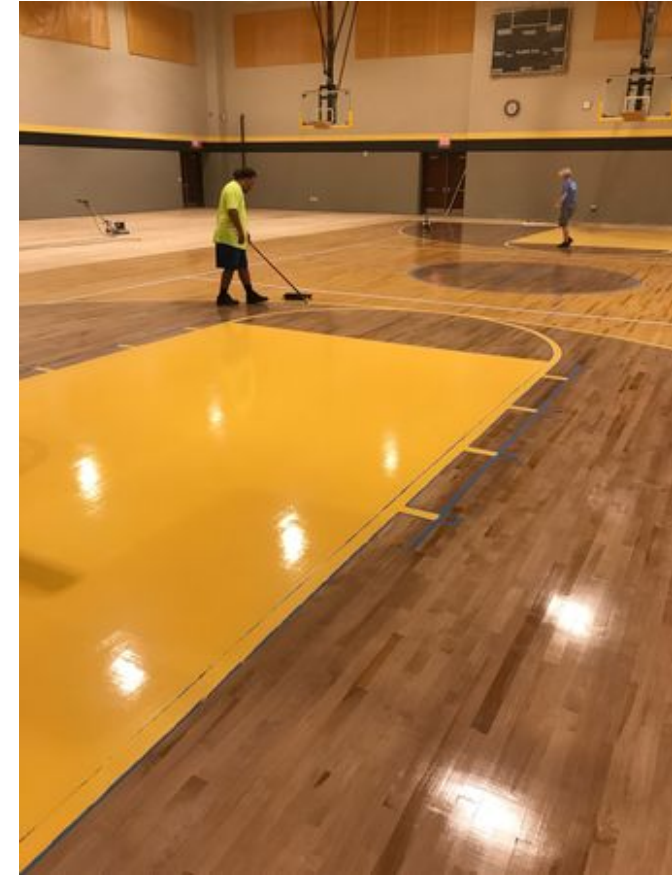
Installation d'un nouveau gymnase
