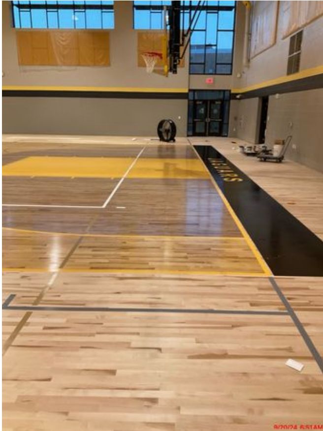
Peinture du sol du gymnase
