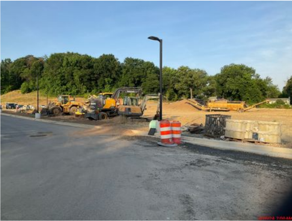
Préparation du site pour l'installation d'un mur de soutènement et d'un terrain de baseball
