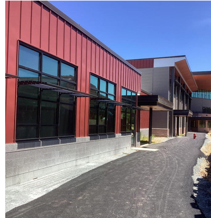
Vía peatonal temporal a la entrada de la escuela
