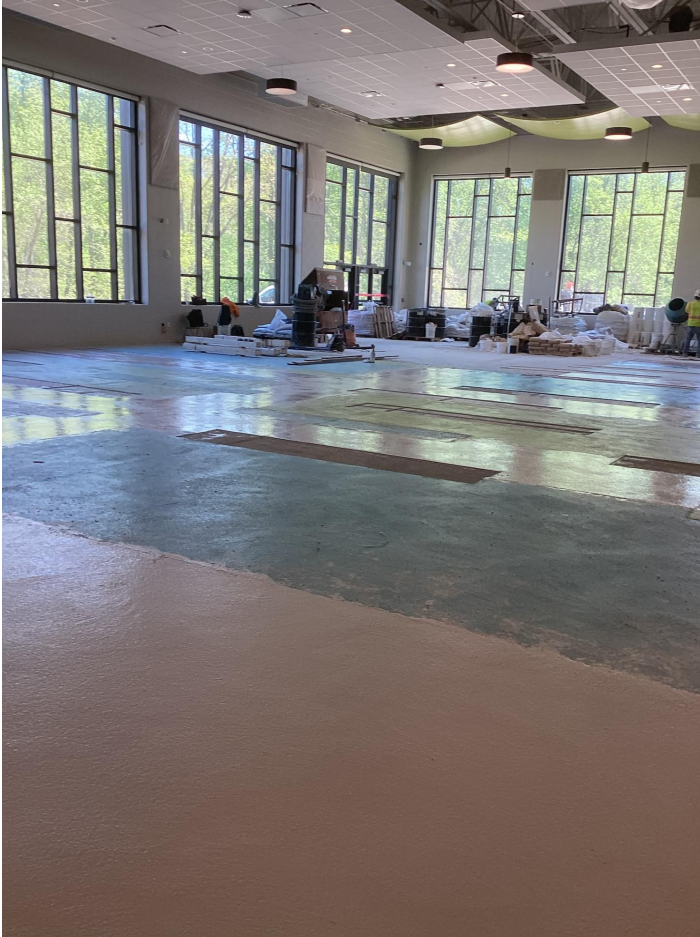
Instalación del terrazo en la cafetería
