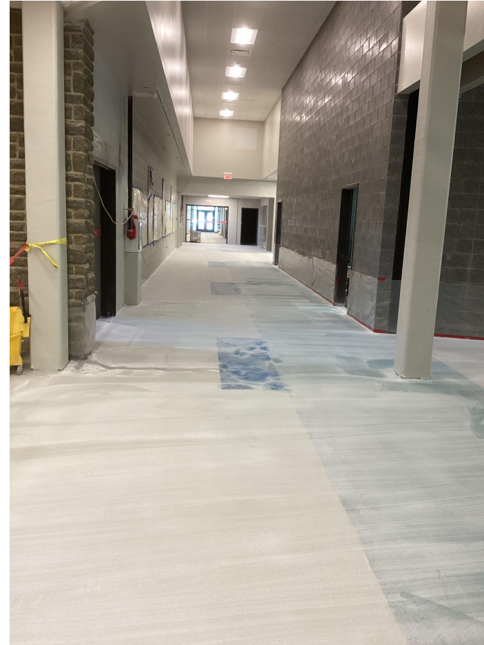
Continuación de la instalación del terrazo en el corredor
