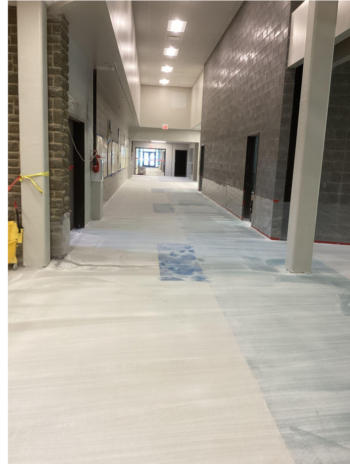
Installation en cours de terrazzo dans le couloir
