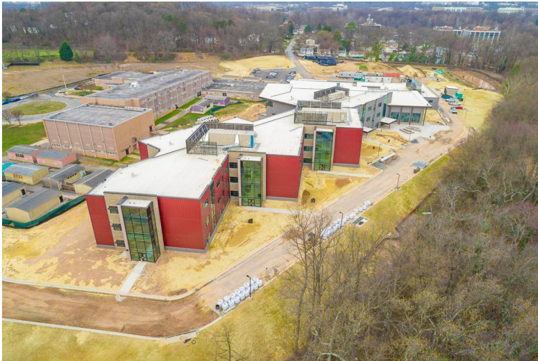
Vue aérienne de la nouvelle installation
