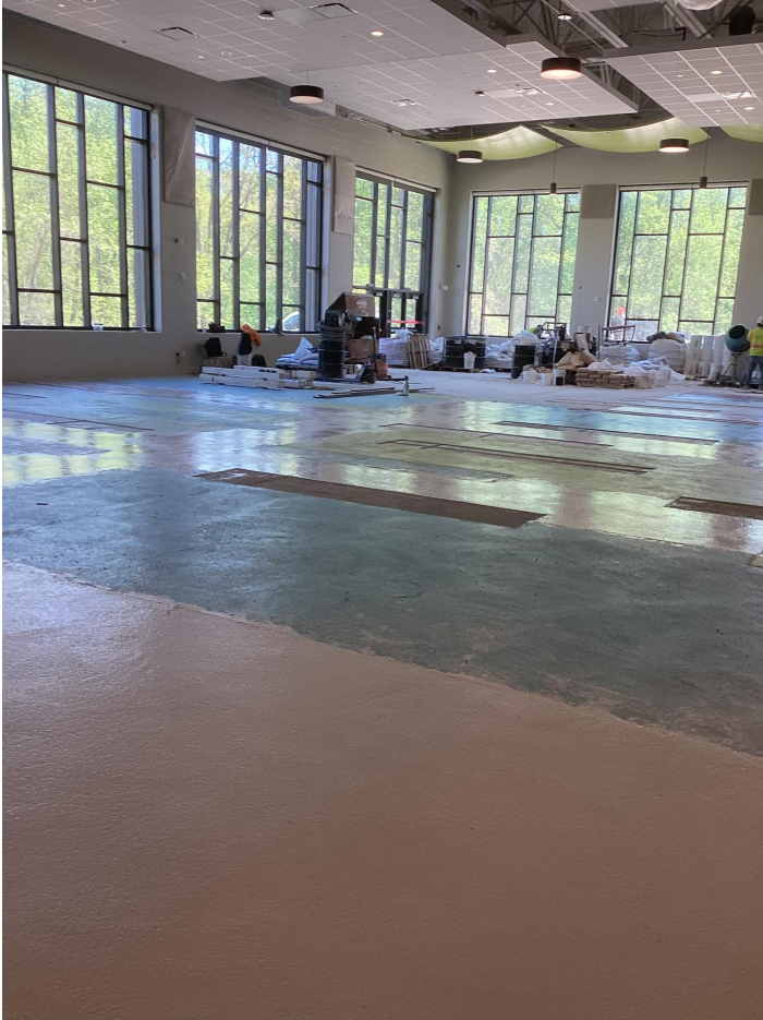
Installation de terrazzo de cafétéria
