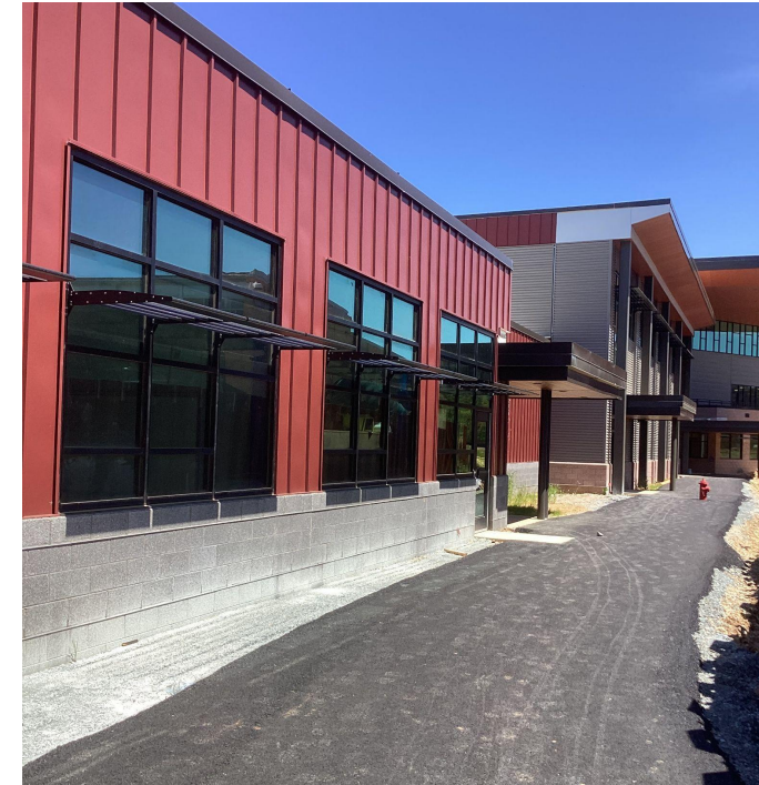
Passerelle temporaire menant à l'entrée de l'école
