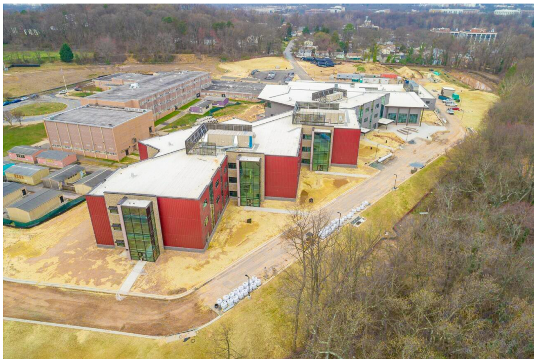
نمای هوایی از تاسیسات جدید
