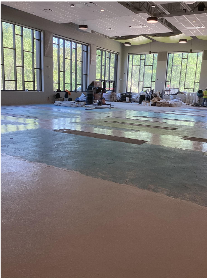
نصب فرش ترازو در طعام خانه
