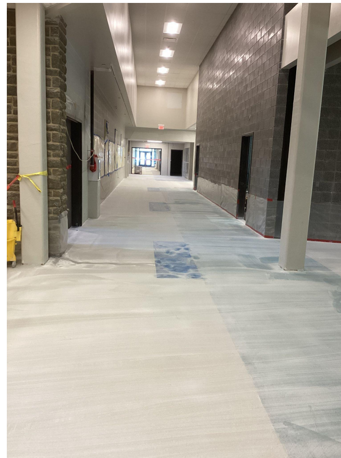
نصب راهرو ترازو در حال انجام
