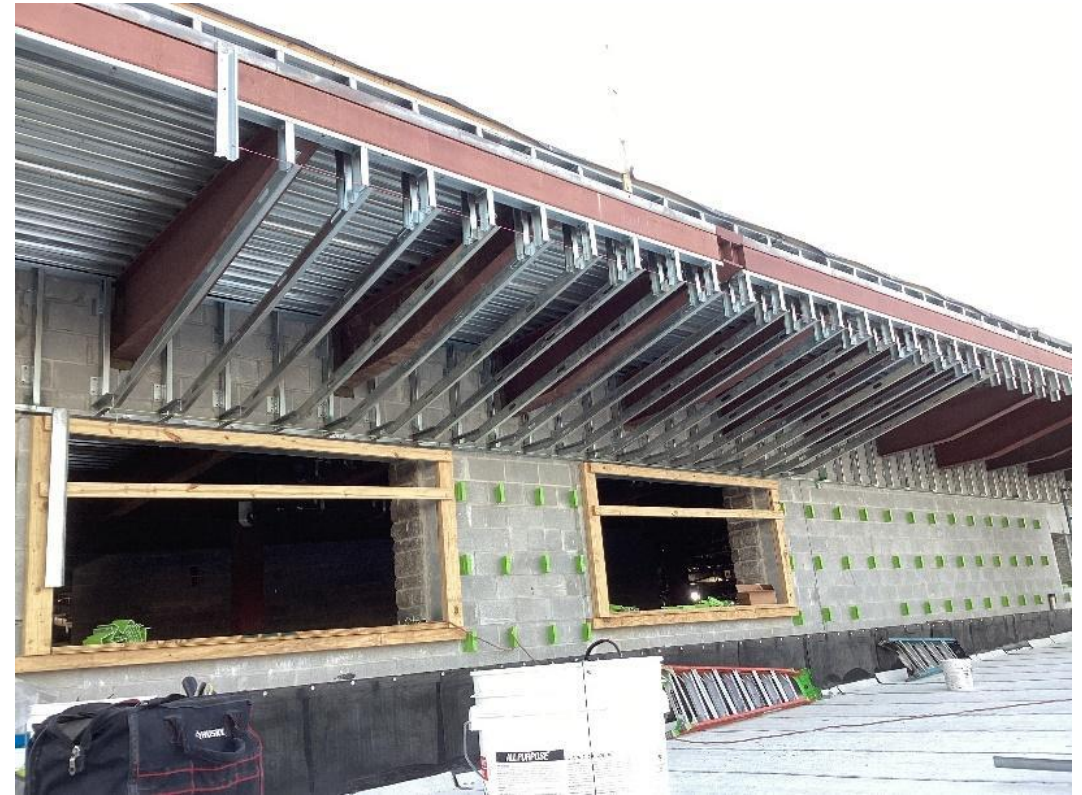
Encadrement des soffites métalliques
