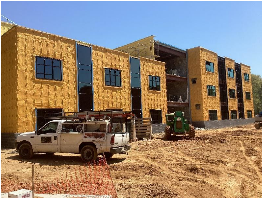
Zone B et C - Mousse pulvérisée, murs-rideaux, fenêtres
