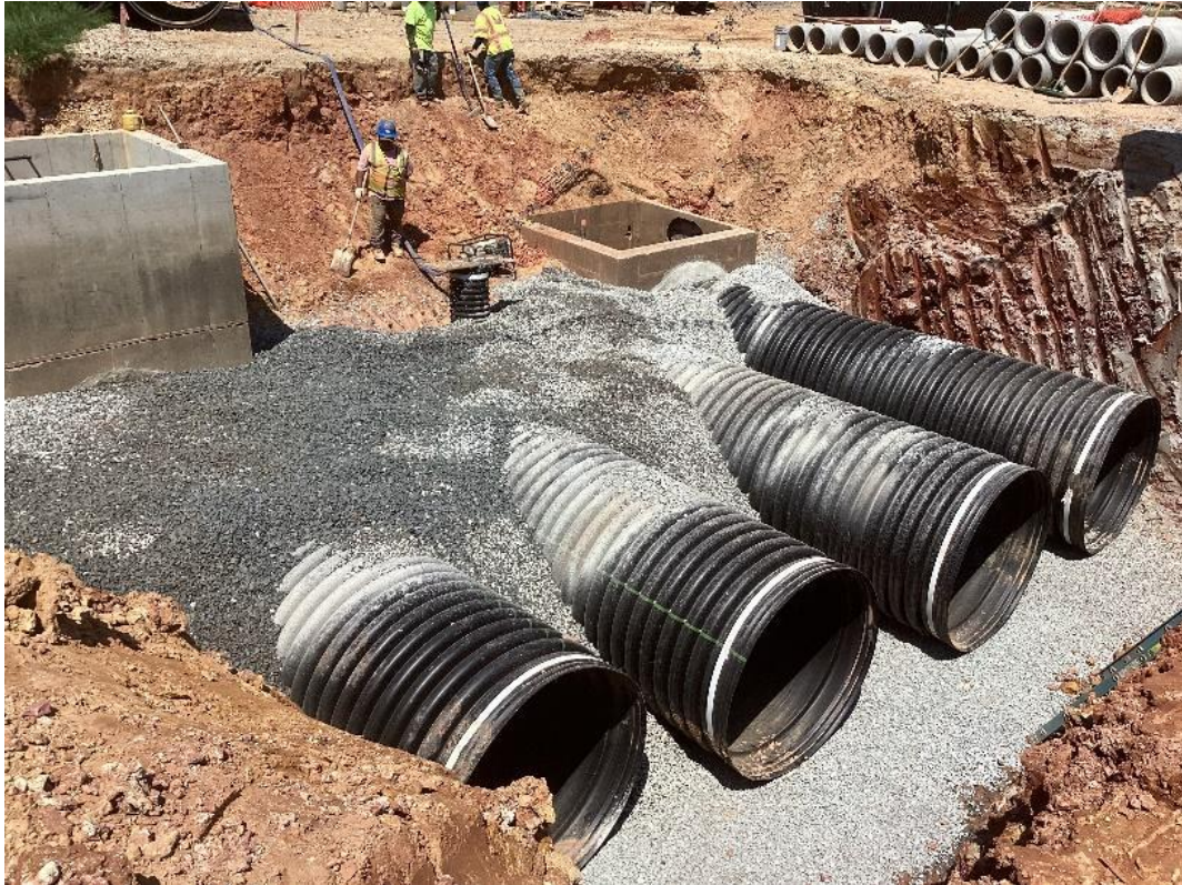
Travaux souterrains pour les eaux pluviales
