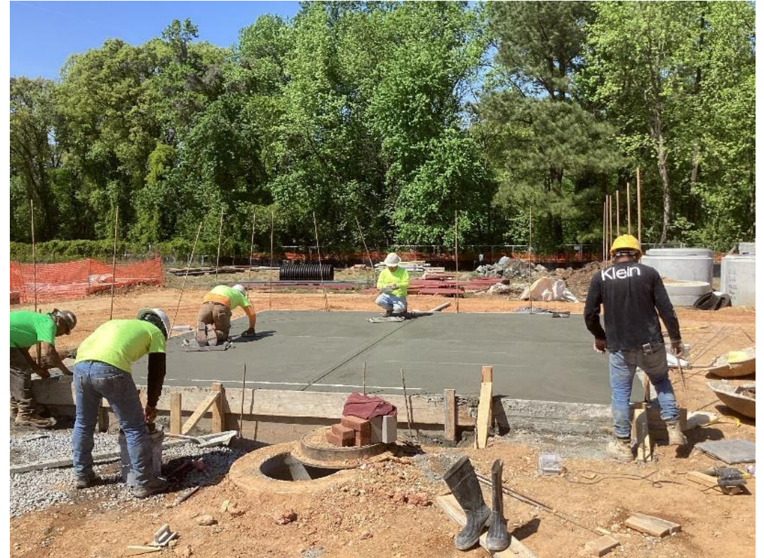
SOG pour le bâtiment des équipements
