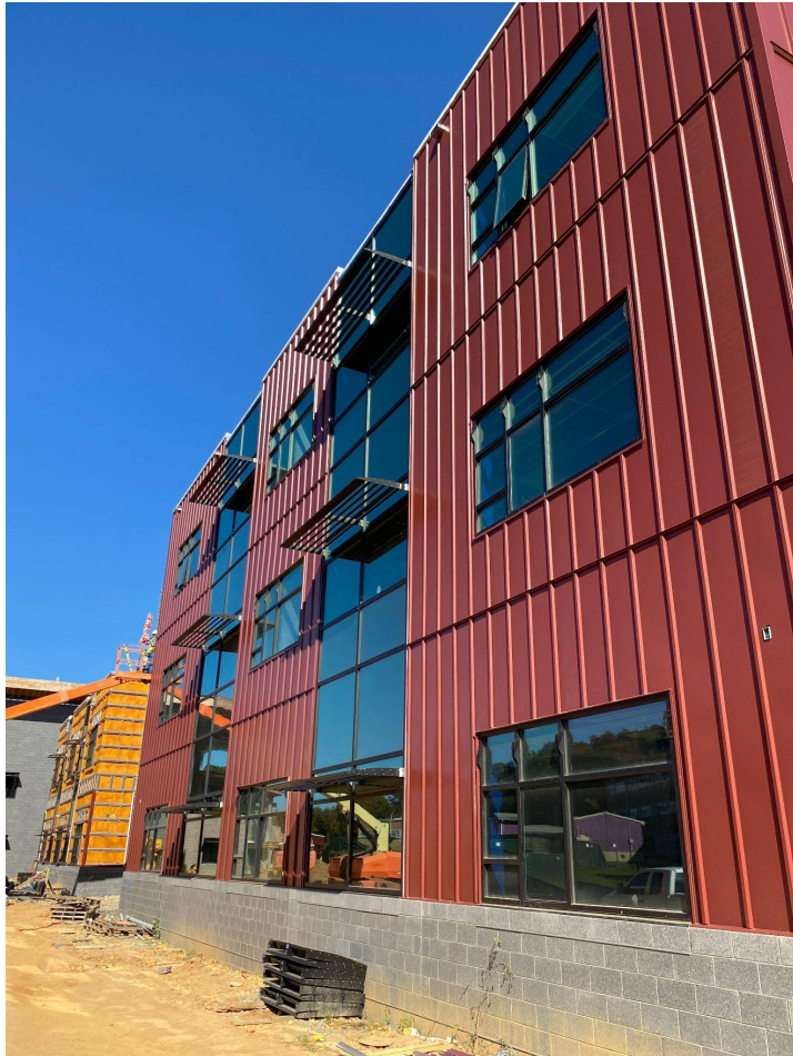
Panneaux métalliques extérieurs
