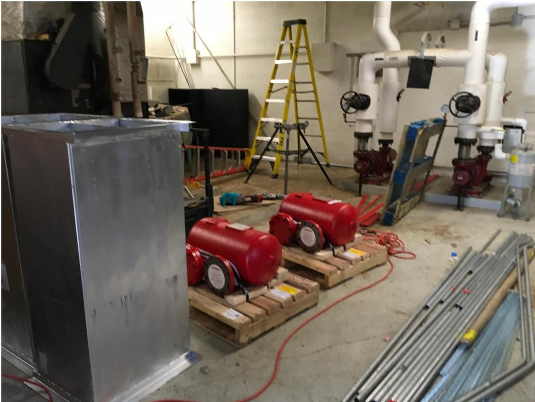
*Extracción de la bomba alternativa existente en el cuarto de calderas*
