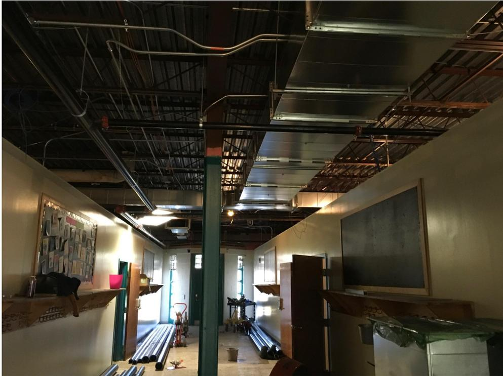
*Conduits nouvellement installés aux POD A, B, C et D*
