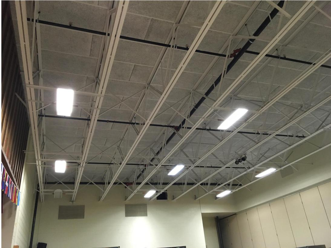
*Tuyaux et têtes d'arrosage nouvellement installés au-dessus de la cafétéria*
