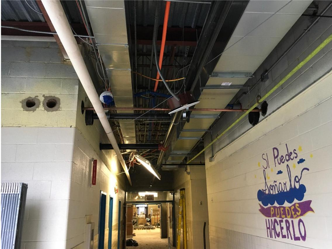
Conduits nouvellement installés dans le couloir
