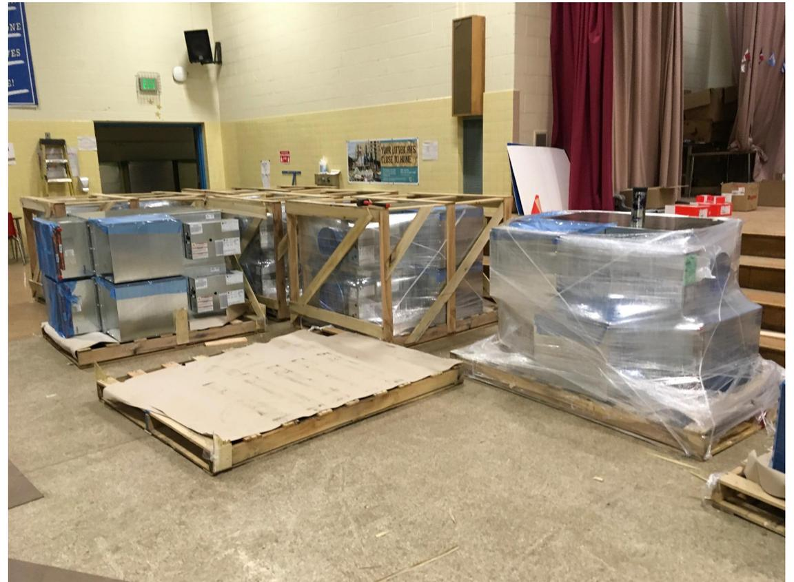
*D'autres VAV ont été livrés et seront déplacés dans différentes pièces, prêts à être installés.*
