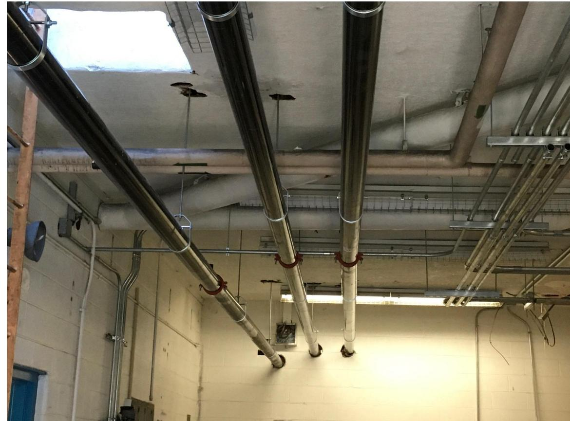
*Tuyaux d'arrosage nouvellement installés reliant le local technique au reste du bâtiment*
