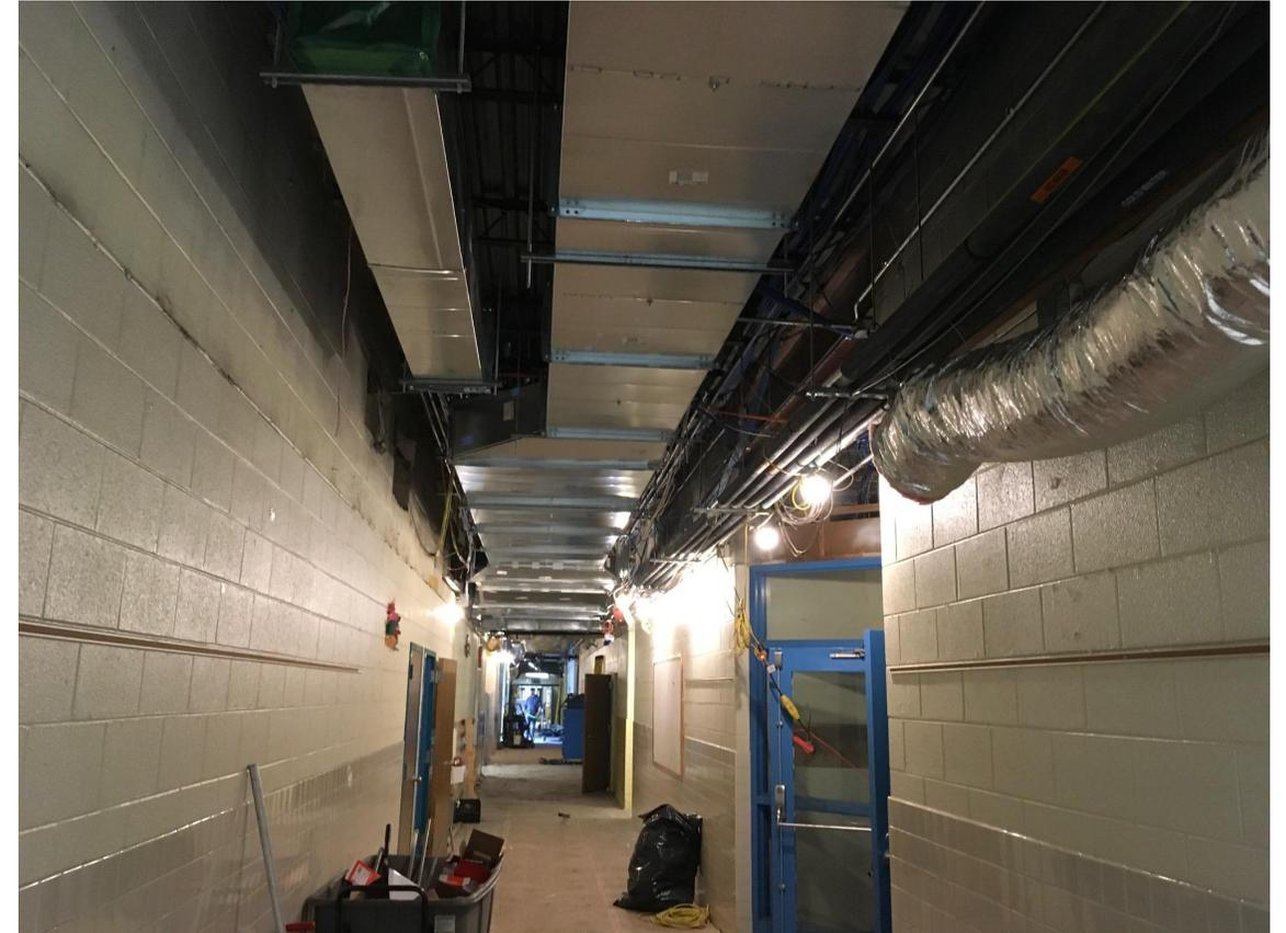
Conduits nouvellement installés dans d'autres parties du bâtiment
