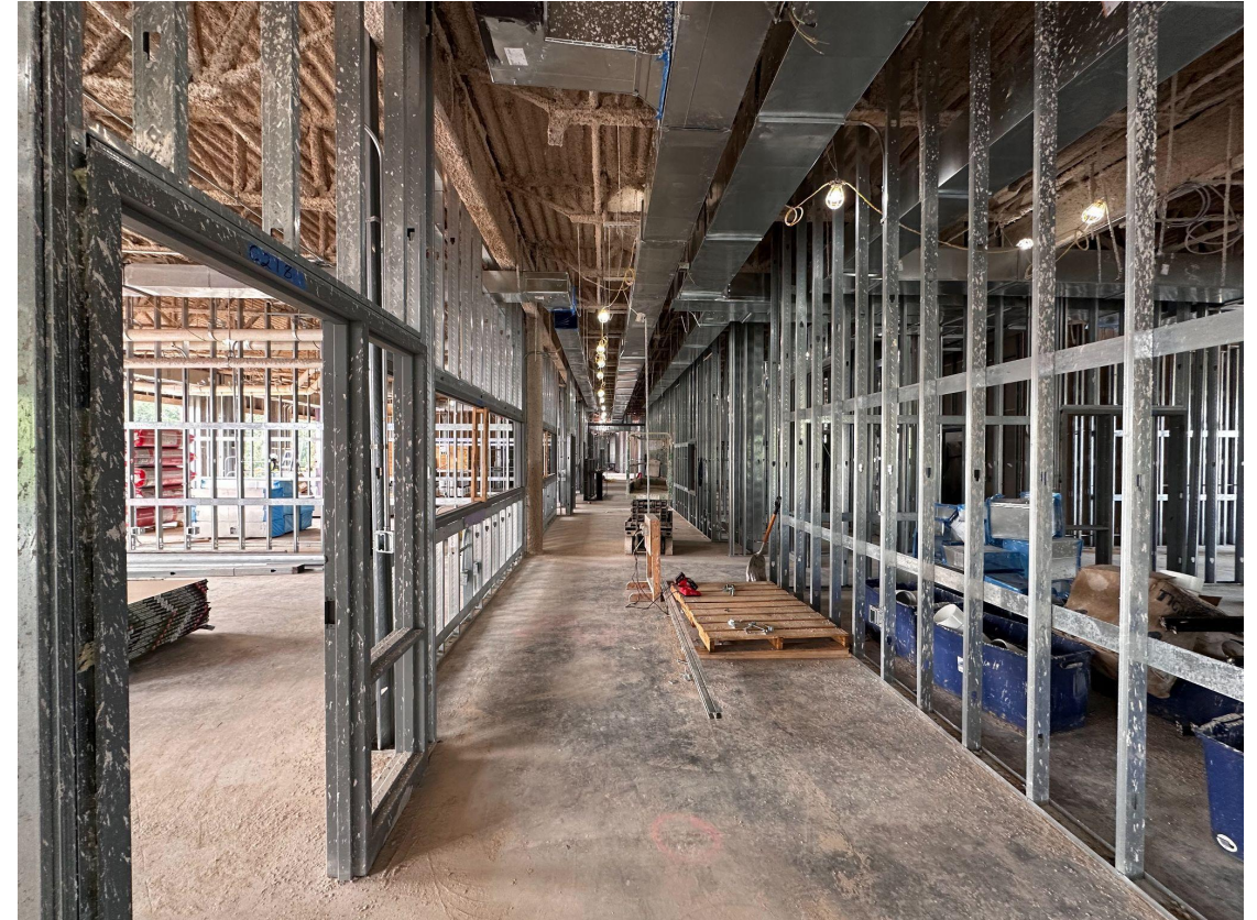
Estructuras de pared y montajes preliminares en un pasillo típico
