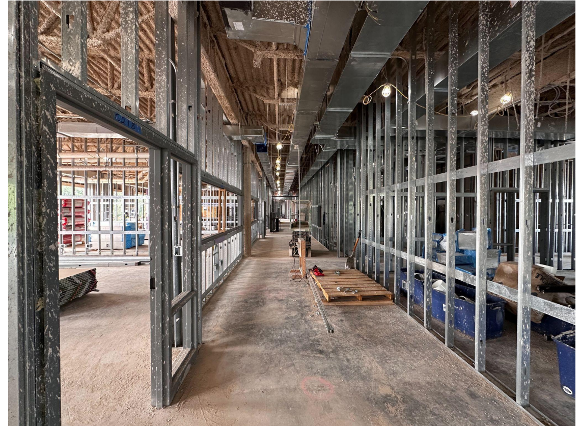
Ossature murale et travaux de gros œuvre dans un couloir typique
