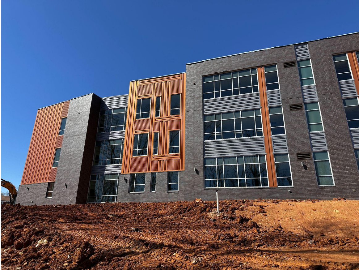
Le côté est du bâtiment montre une aile de 3 étages pour les salles de classe
