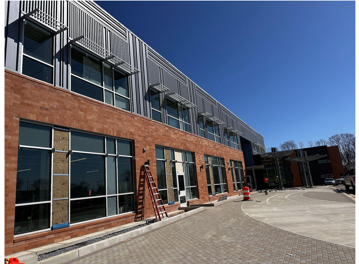
Place d'entrée principale
