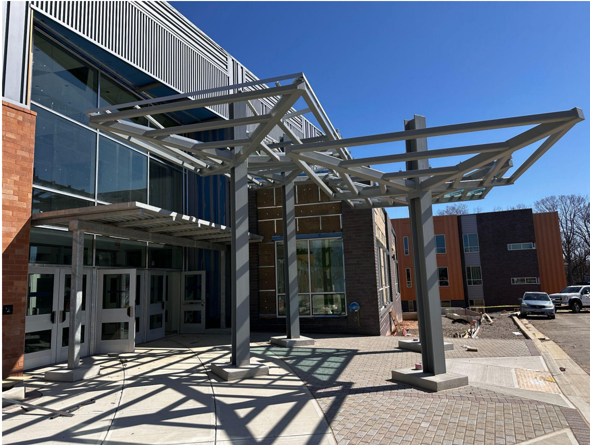
Entrée principale de l'école avec « auvents d'arbres »
