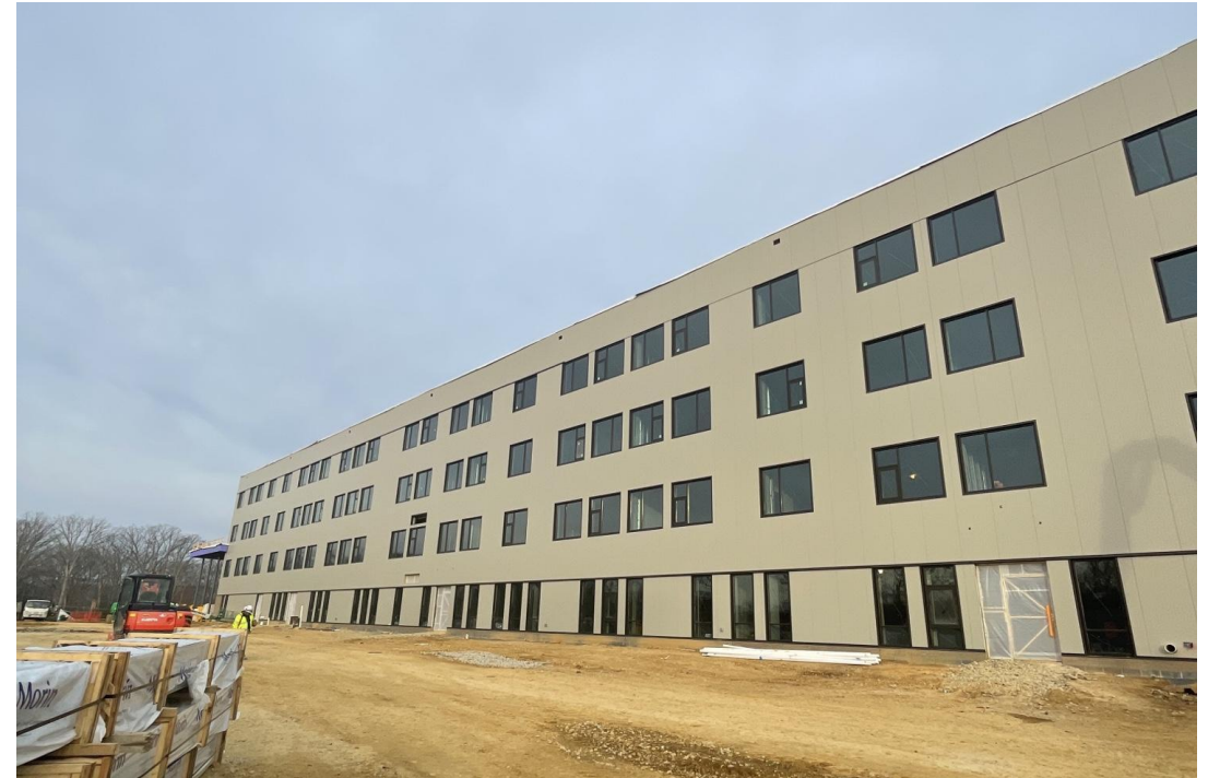
Vista de la torre de 4 pisos.
