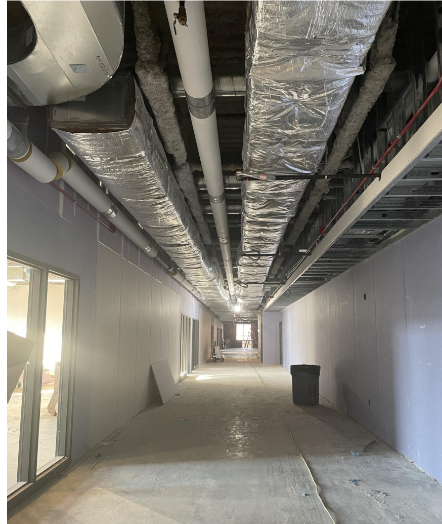
Corredor en el nivel 2 de la torre de 4 pisos.
