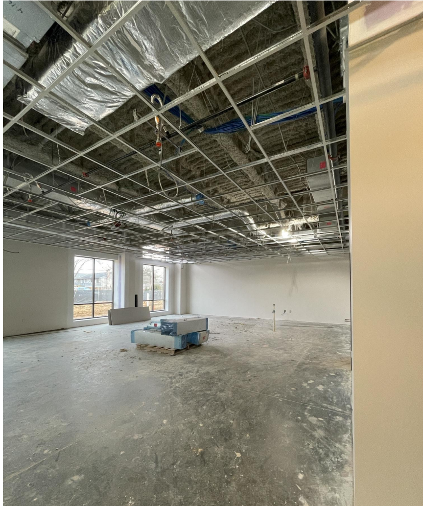
Salón de clases en el nivel 1 de la zona norte.
